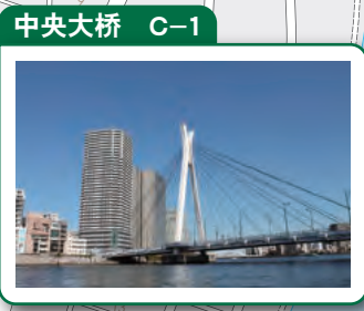
中央大桥 C-1
