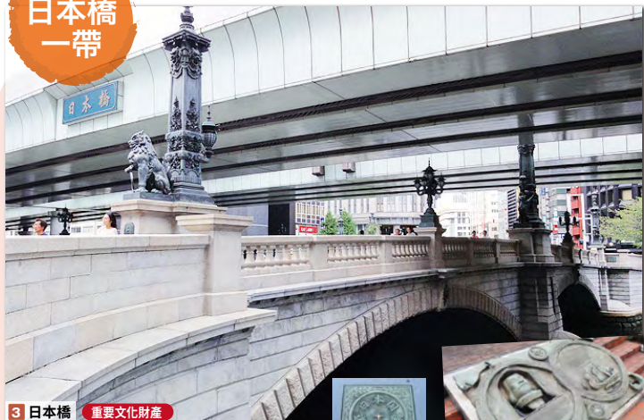
3 日本橋 重要文化財産
