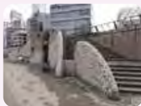
両国橋下流の階段や防潮堤壁面は意匠を凝らした造り。
