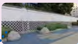
なまこ壁風の防潮堤。
