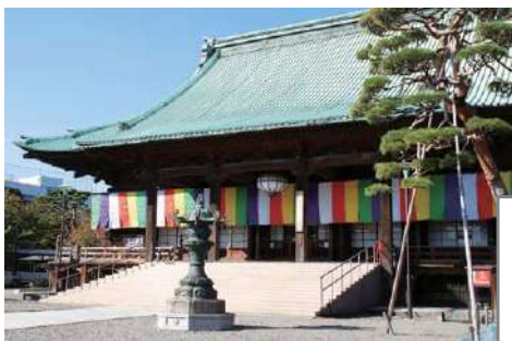
장군의 지시로 지어진 관음당(본당)은 건축 공예의 정수를 집대성한 대간축출. 그 웅장함은 도내 최고로 평가받고 있습니다.
