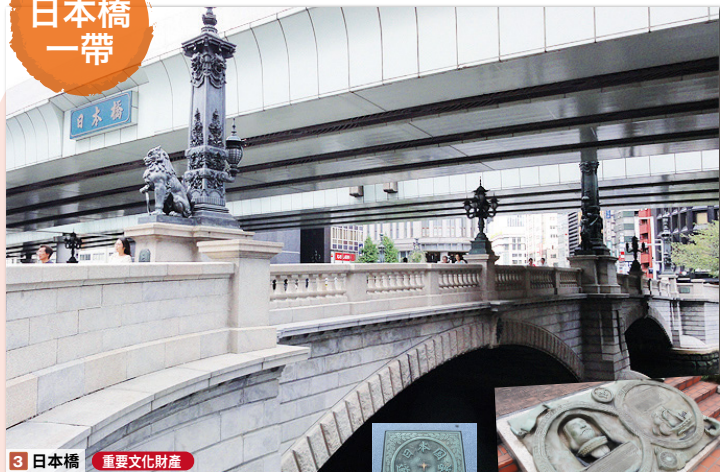
3 日本橋 重要文化財產
