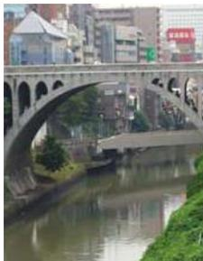
昭和2年(1927年)作為關東大地震的復興橋，架設在神田川上的鋼筋混凝土拱橋。作為連接湯島聖堂和尼古拉堂的橋，透過公開募集而得名。
