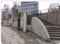
隅田川下流の階段や防潮堤壁面は意匠を凝った造り。
