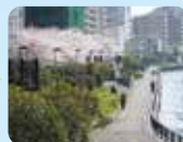
佃大橋下流側
