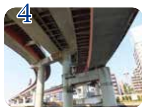
4 真下から見上げる高速道路は迫力大
