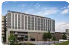
ヒューリック両国リバーセンター スーパー堤防に面する2階に「水上バス待合所」、同じく2階から9階には「ザ・ゲートホテル両国 by HULIC」、「両国子育てひろば」等が入る複合施設です。
