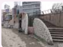
両国橋下流の階段や防潮堤壁面は意匠を凝った造り。
