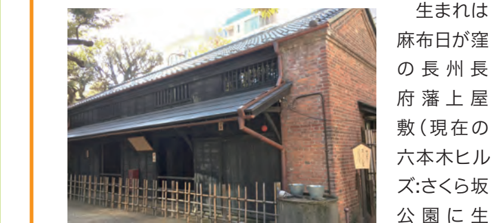
乃木旧邸馬屋(住居より先に建てられた)
