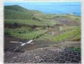
②多摩産材を使用した樹木と御蔵島。金曾沢の復旧工事。
