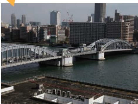
昭和15年(1940)に竣工した双葉跳開橋で、完成時には東洋一の可動橋と呼ばれました。当初は1日5回跳開していましたが、昭和45年(1970)を最後に開閉が停止となっています。
