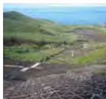
②多摩産材を使用した樹木と御蔵島。金曽沢の復旧工事。
